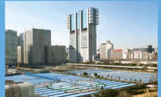
環境モデルビルが建設される芝浦水再生センター
