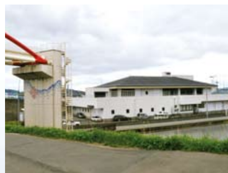
▲主要ポンプ場の集中監視制御が行われている ポンプ場管理センター（大瀬ポンプ場内）
