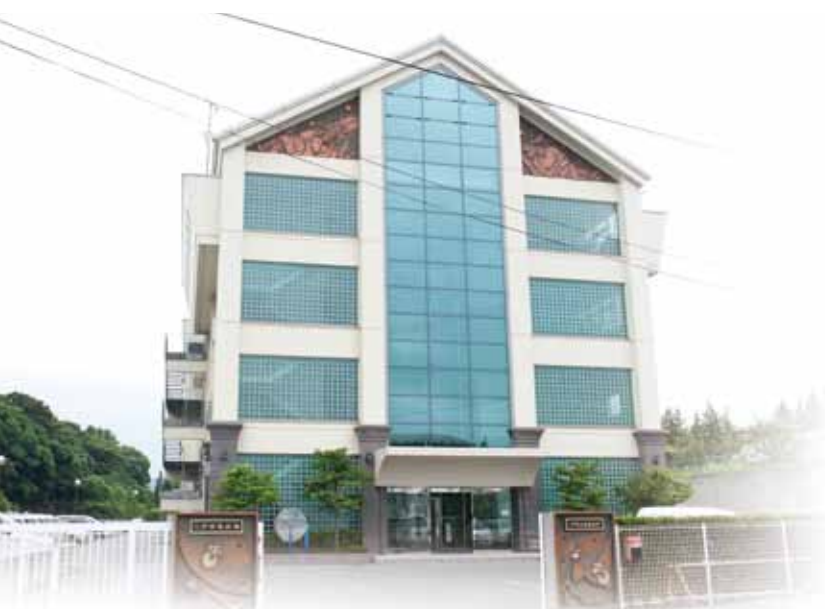
▲ 二戸市浄水場の管理棟
