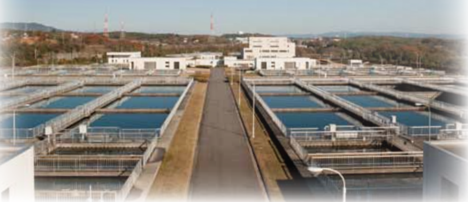
◀愛知用水地域にある尾張東部浄水場（写真奥の白い建物に、PFI事業の対象である脱水施設が設置されています）
