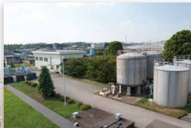
▲公設民営で運営されている柿木浄水場
