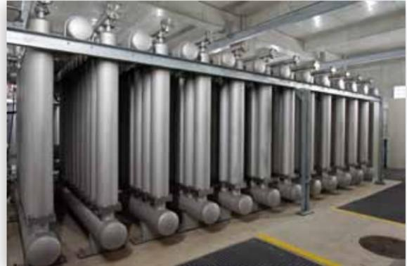
写真2 セラミックろ過装置
