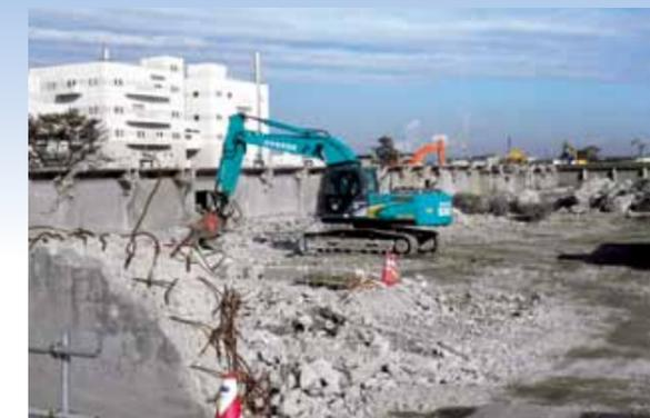
▲再建に向けて作業が進む南蒲生浄化センター(生物反応槽の取り壊し状況。写真提供:仙台市)
