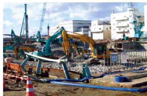
▲再建に向けて作業が進む南蒲生浄化センター(最終沈殿池の取り壊し状況。写真提供:仙台市)
