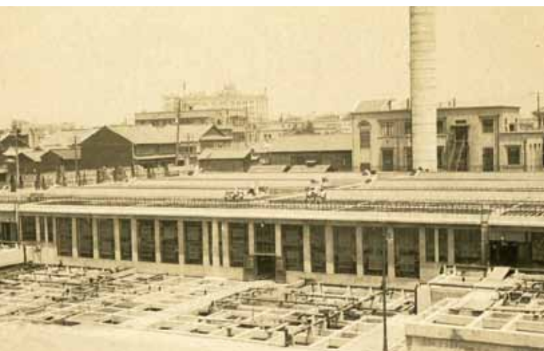
◀写真1 供用開始当時の堀留処理場
