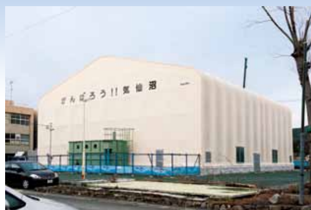
▲写真2 気仙沼市が設置した仮設污水处理施設のうち、ホテルや食堂の近くでは周辺環境に配慮して施設全体がテントで覆われています
