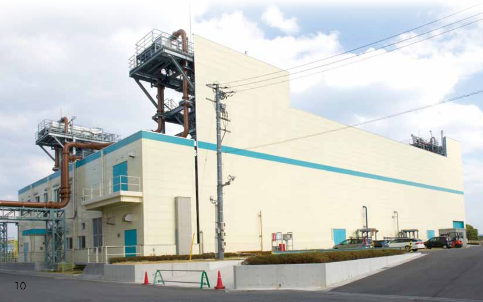
▼写真1 西部下水汚泥燃料化施設の外観
